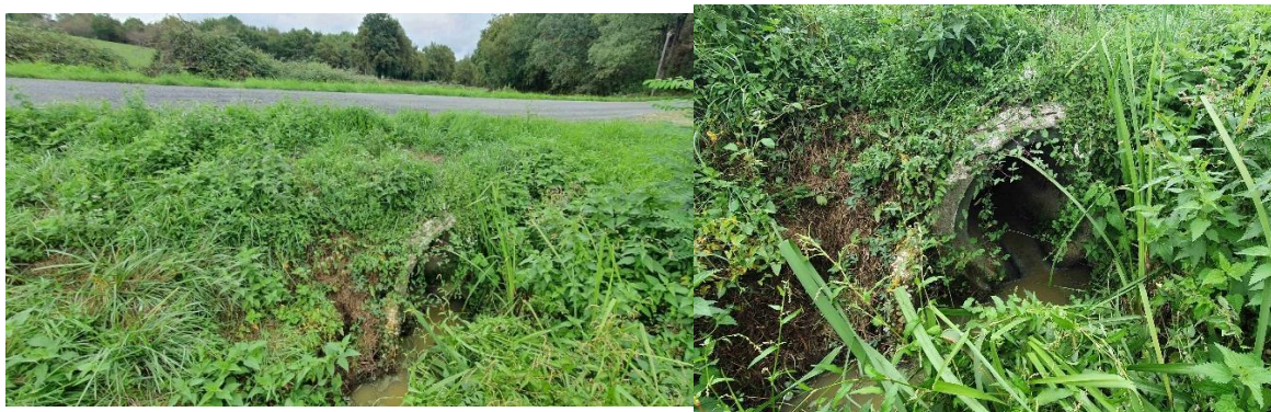
Figure 1 : Photo amont de la buse (gauche) et aval (droite)
