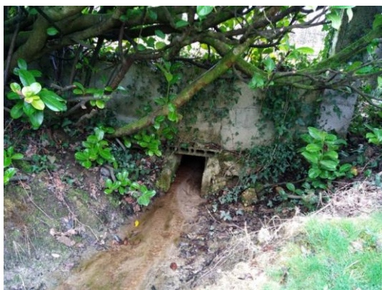
Figure 6 : Vue amont de l'ouvrage sur le lit en fond de vallée, le 18.01.2022
