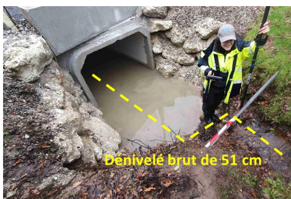
Figure 7 : Vue amont du nouveau pont cadre juste après les travaux, le 02.12.2025
