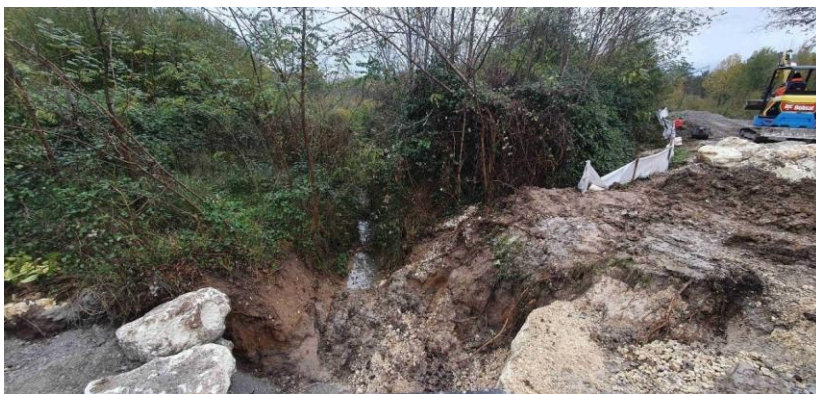
Figure 21 : Linéaire à l'aval immédiat du pont cadre. Ici, seul le lit est à libérer à minima pour permettre l'écoulement des eaux (pas les berges)
