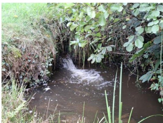
Figure 5 : Vue aval du passage busé DN500 sur le lit perché, le 22.09.2025
